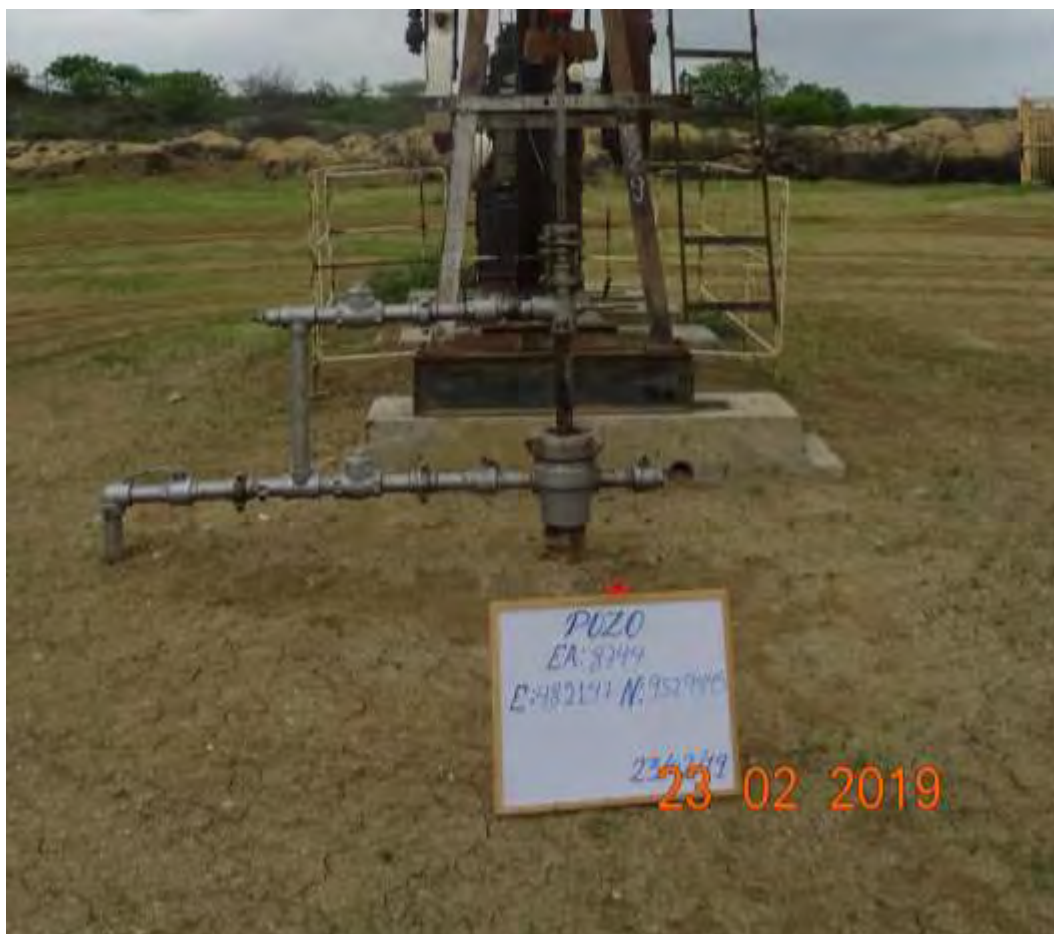
Fotografía 1. Pozo EA8744 (Coordenadas WGS84-zona 17S: 482147mE, 9529445mN), pozo productor tipo BM. Vista desde cerca del pozo. Sin indicio de derrame de hidrocarburos y alteración de suelo.
