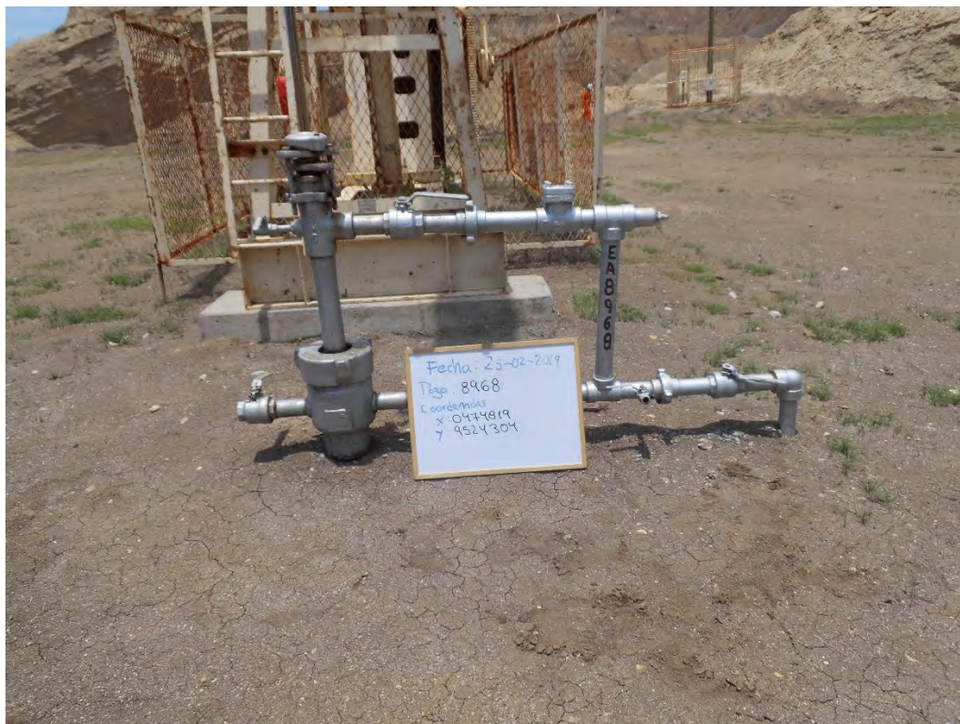
Fotografía 1. Pozo EA8968D (Coordenadas WGS84-zona 17S: 481027mE, 9518348mN), pozo productivo tipo BM. Vista desde cerca del pozo. Sin indicio de derrame de hidrocarburos ni alteración de suelo.
