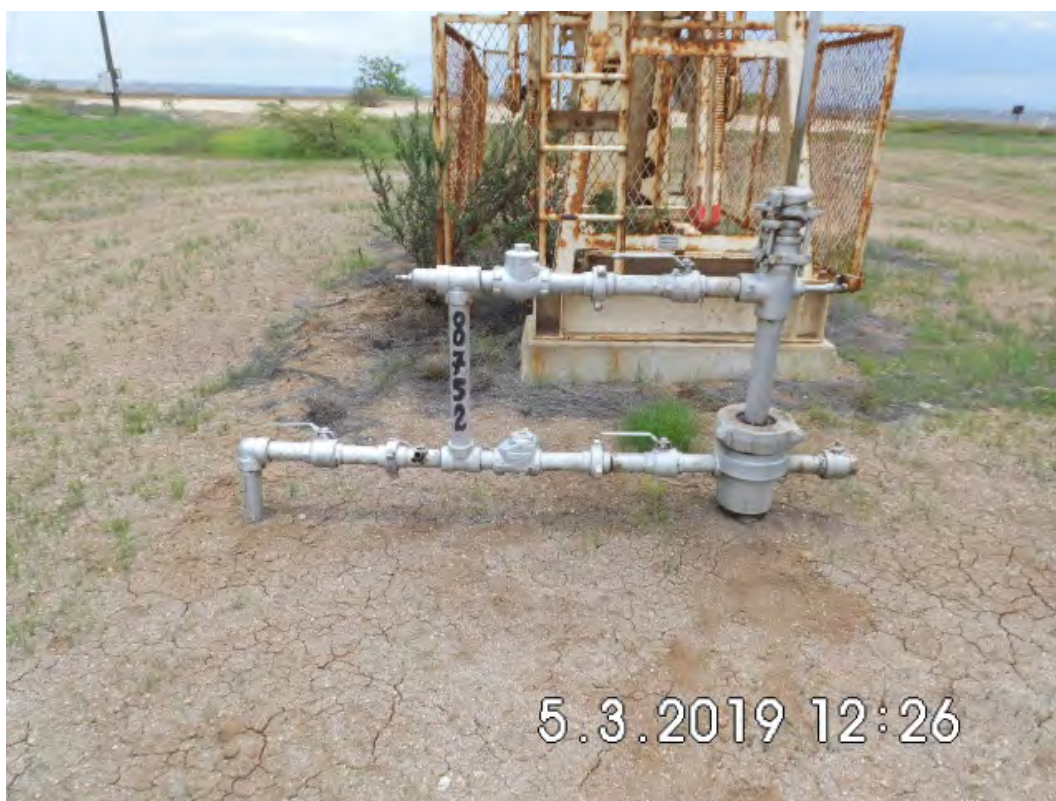
Fotografía 1. Pozo EA8752 (Coordenadas WGS84-zona 17S: 473302mE, 9524748mN), pozo productor tipo BM. Vista desde cerca del pozo. Sin indicio de derrame de hidrocarburos ni alteración de suelo.
