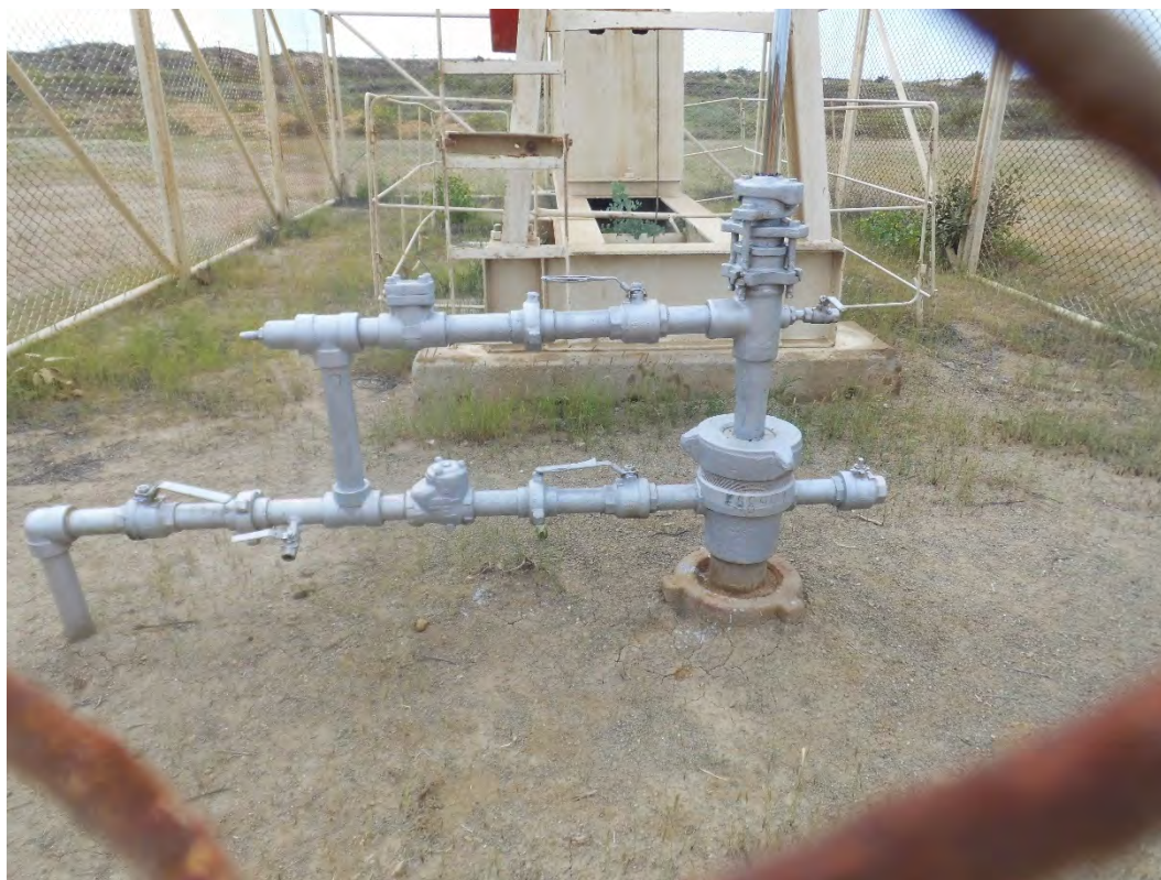
Fotografía 1. Pozo EA8949D (Coordenadas WGS84-zona 17S: 477491mE, 9528854mN), pozo productor tipo BM. Vista desde cerca del pozo. Sin indicio de derrame de hidrocarburos ni alteración de suelo.
