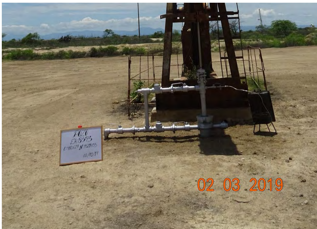
Fotografía 1. Pozo EA8593 (Coordenadas WGS84-zona 17S: 480629mE, 9529455mN), pozo productor tipo BM. Vista desde cerca del pozo. Sin indicio de derrame de hidrocarburos ni alteración de suelo.
