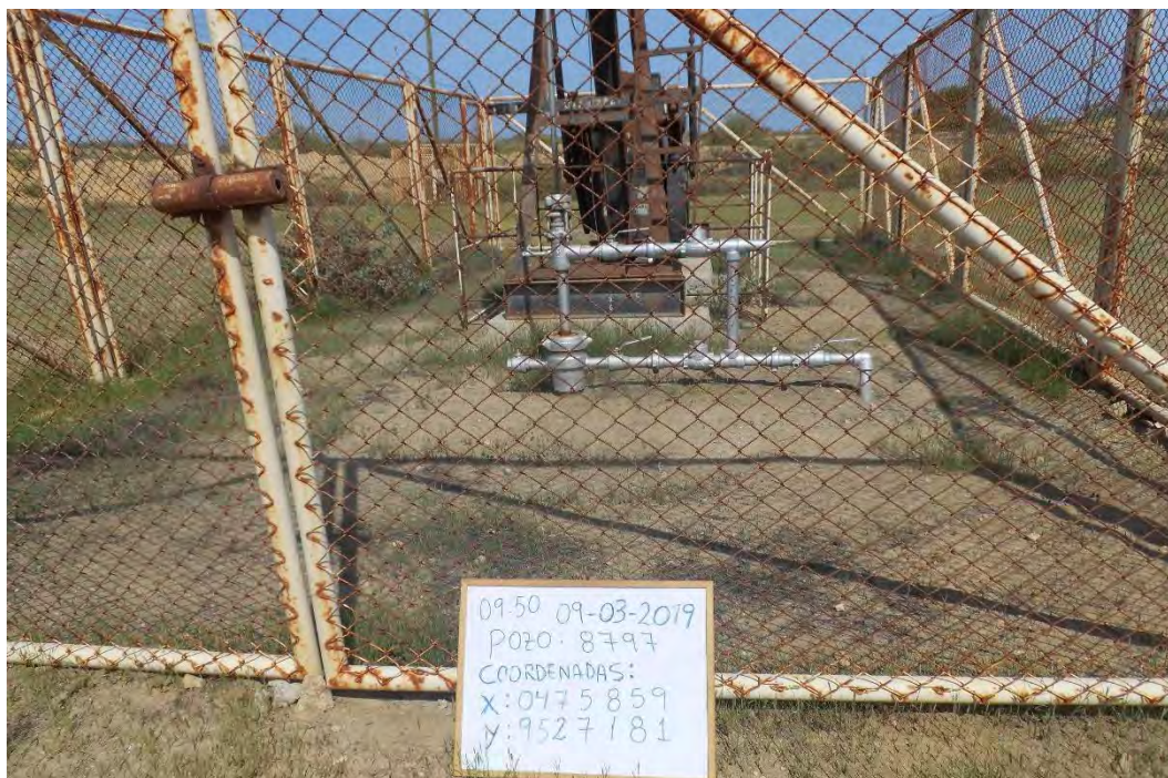
Fotografía 1. Pozo EA8797 (Coordenadas WGS84-zona 17S: 475859mE, 9527181mN), pozo productor tipo BM. Vista desde cerca del pozo. Sin indicio de derrame de hidrocarburos ni alteración de suelo.
