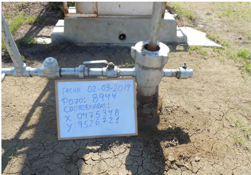
Fotografía 1. Pozo EA8944 (Coordenadas WGS84-zona 17S: 475348mE, 9526721mN), pozo productivo tipo BM. Vista desde cerca del pozo. Sin indicio de derrame de hidrocarburos ni alteración de suelo.
