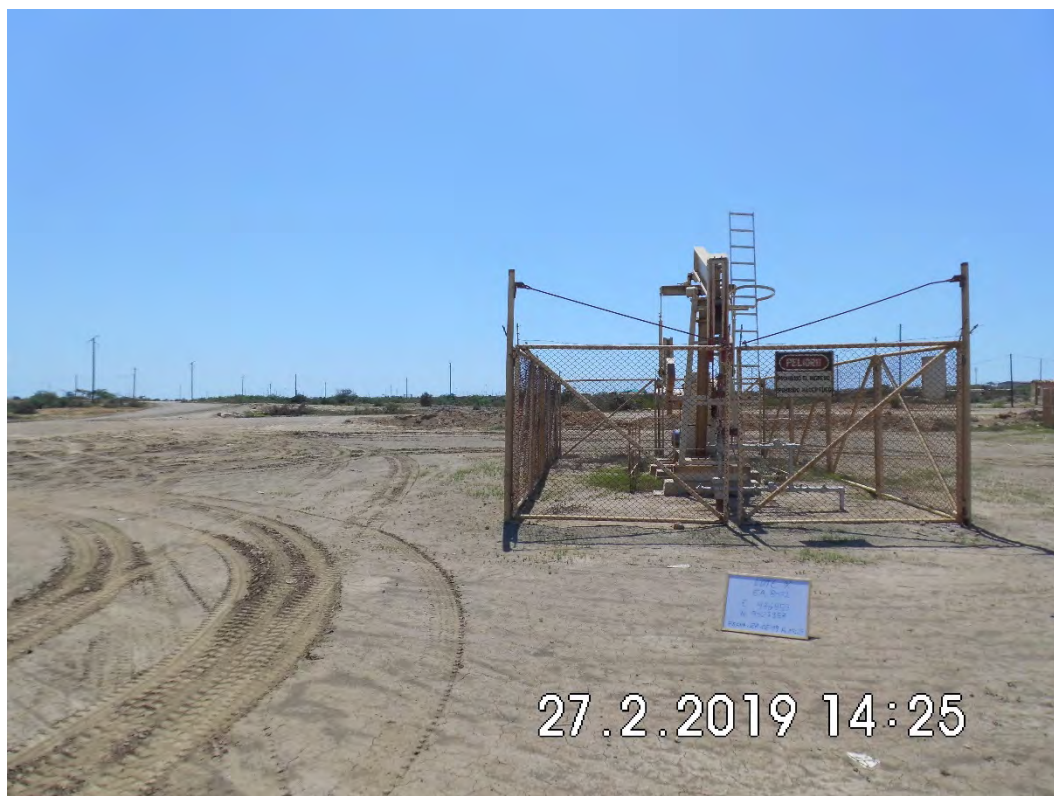
Fotografía 1. Pozo EA8472 (Coordenadas WGS84-zona 17S: 476953mE, 9527795mN), pozo productivo tipo BM. Vista desde cerca del pozo. Sin indicio de derrame de hidrocarburos ni alteración de suelo.
